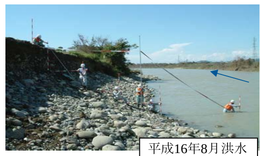
図-2.6 低水護岸の被災（香南市深淵地先）
