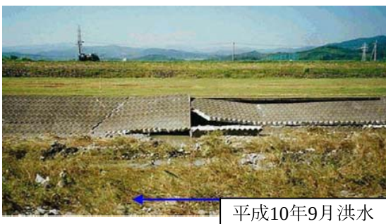
図-2.5 低水護岸の被災（香美市岩積地先）
