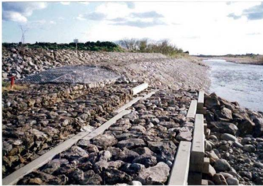
施工直後の状況
