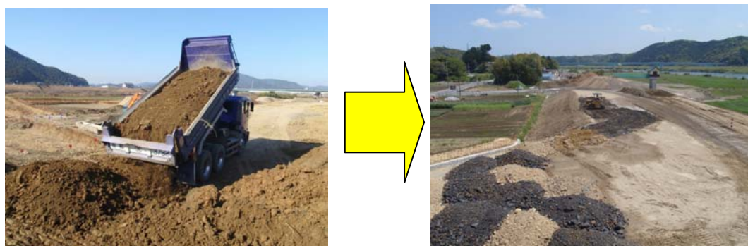
図 8.1 他工事からの建設発生土を盛土材として有効利用
