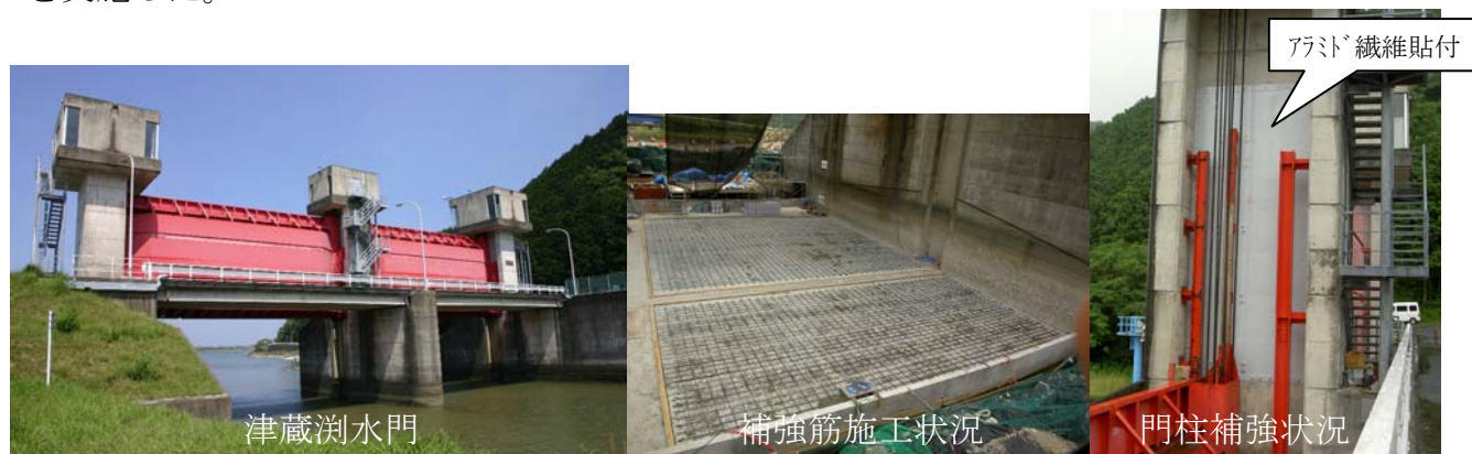
図 5.3 津蔵渕水門の耐震補強状況
