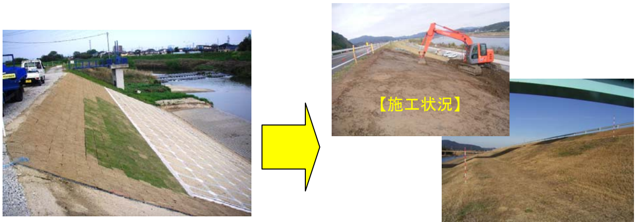
図 8.2 従来の植生工（張芝）と新たな植生工（現地植生）
