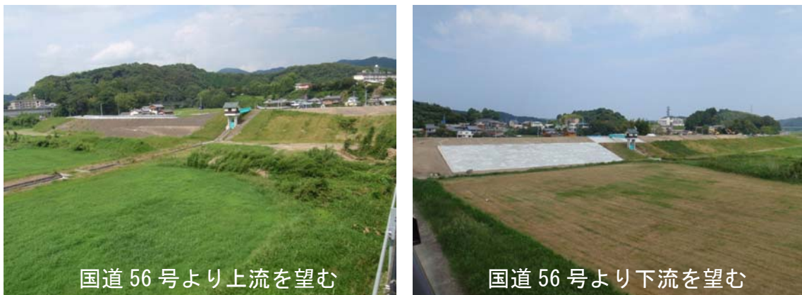
図 5.1 不破箇所での築堤事業
