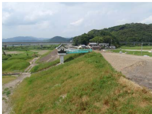
図 9.1 現地植生による堤防法面
