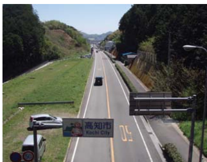
②：高知西トンネル付近の状況
