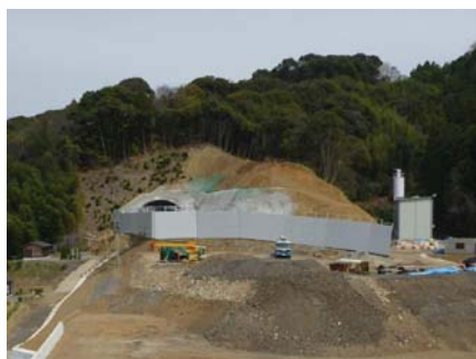
④：是友トンネル（仮称）付近の状況
