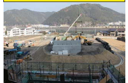
② 岩松川右岸から左岸側
