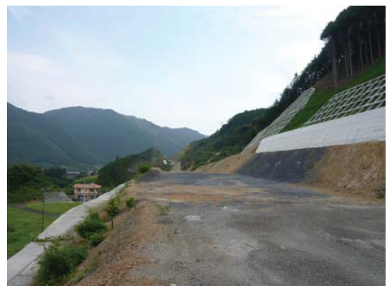
⑥施工状況(押ノ川地区)
