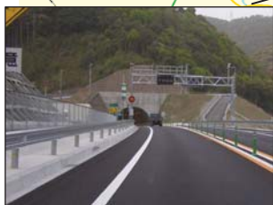
【安和川橋～ 焼坂第1トンネル坑口】
