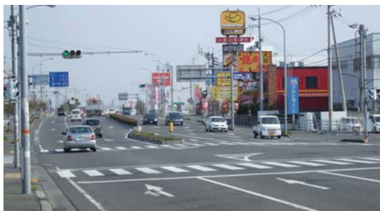
●4車線化が完了した整備済み区間
