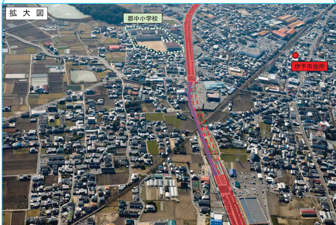
●未整備区間（JR跨線橋付近） 【撮影平成 23 年 2 月】
