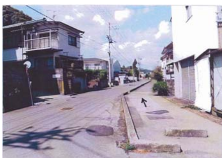
「せせらぎ水路」の整備前
