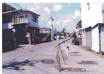
せせらぎ水路の整備前
