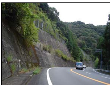
防災点検箇所
