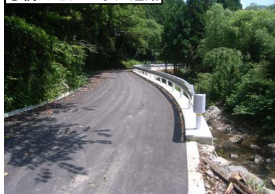
② 橋川地区工事用道路
