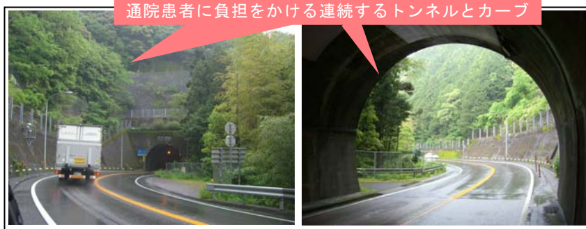
一般国道 56 号トンネル・カーブの状況
