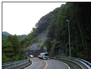
防災点検箇所
