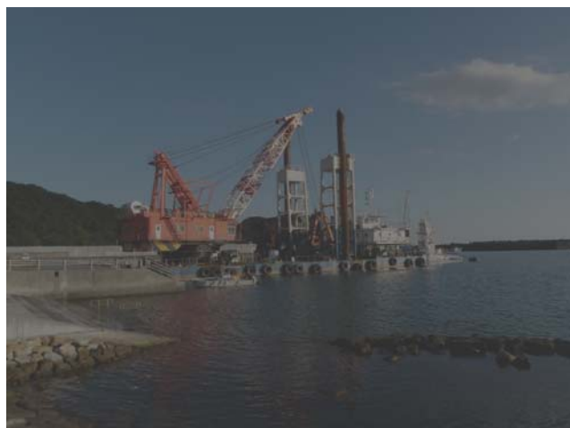
工事用船舶避難状況
