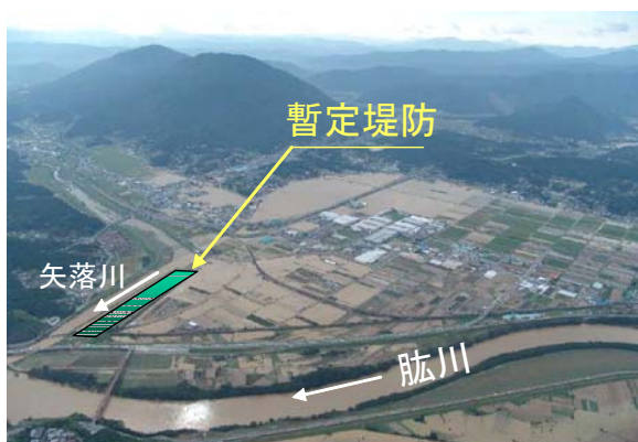
大洲盆地浸水状況（H16年台風16号）
