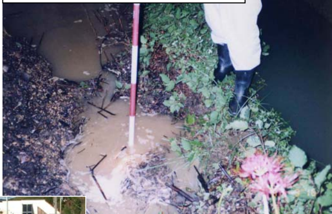
安並堤防の漏水被害 平成9年9月洪水
