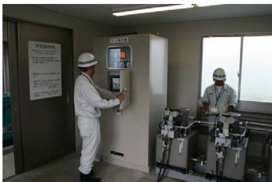
機械設備の点検（1）
