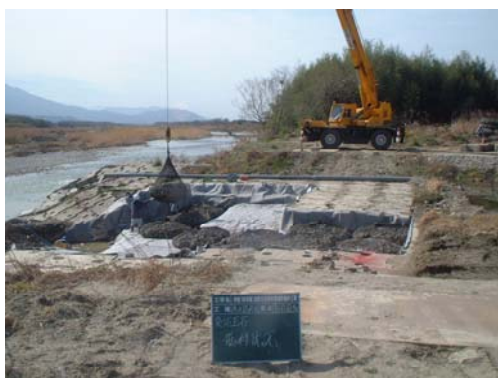
樋門吐出部周辺護岸補修
