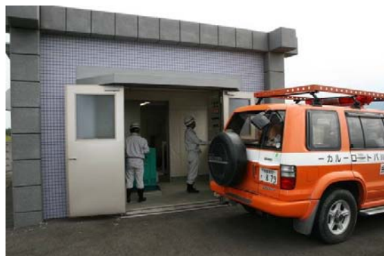
機械設備の点検（2）
