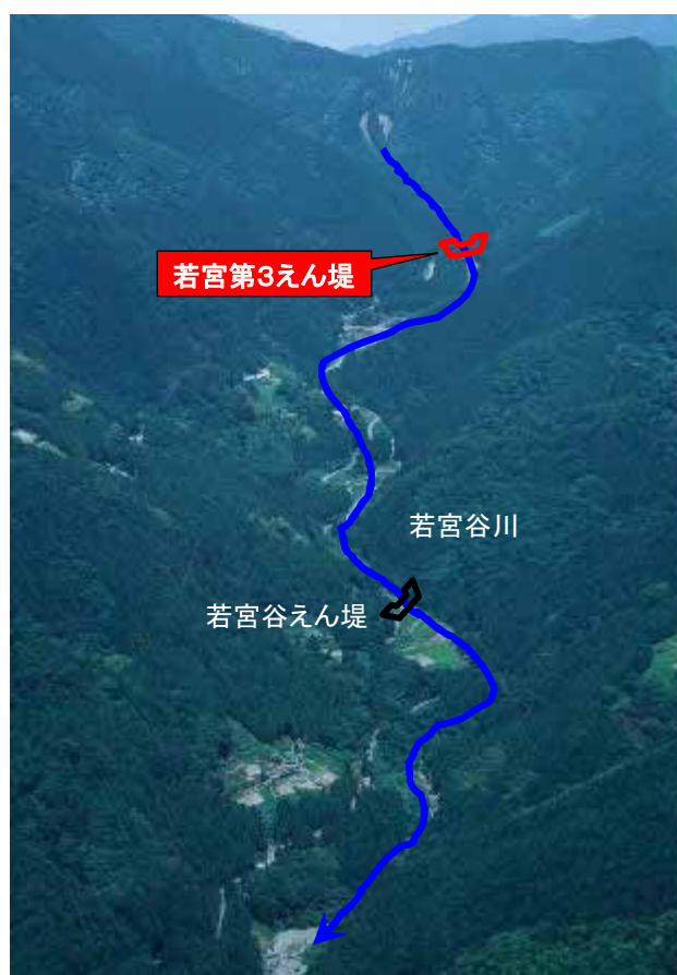
写真-5 若宮谷第3えん堤整備箇所
