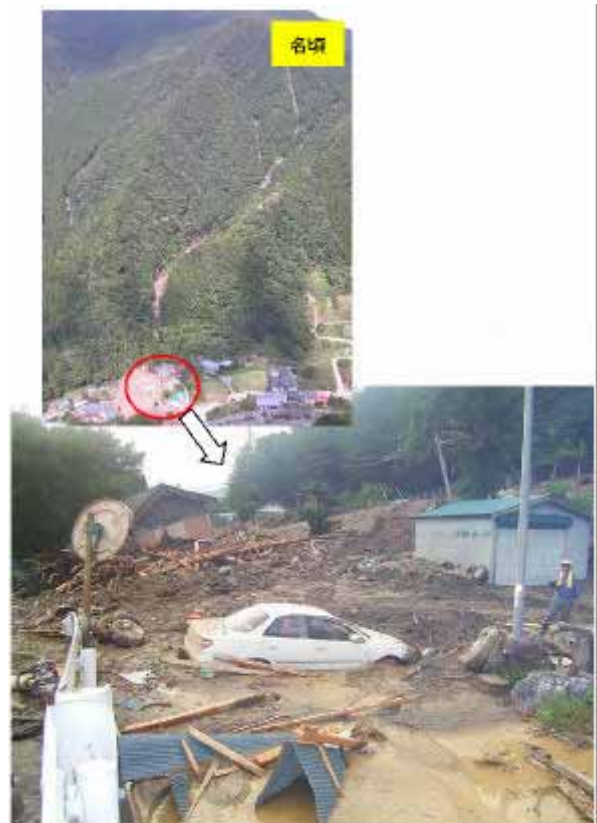
写真-11 平成16年8月台風16号豪雨により名頃地区で発生した土石流災害
