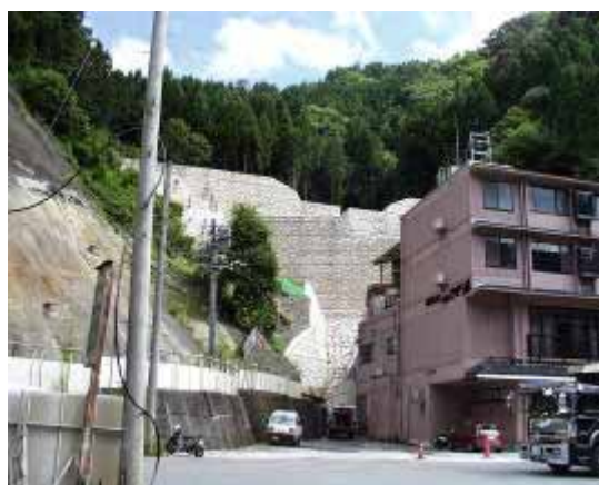
写真-25 とびのす谷えん堤
