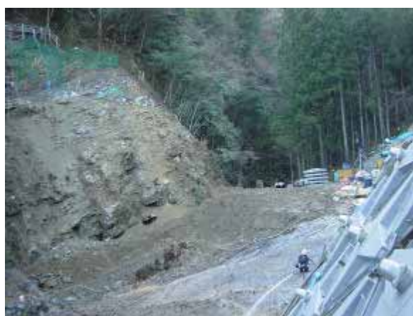
写真-21 熊谷第3 えん堤施工箇所
