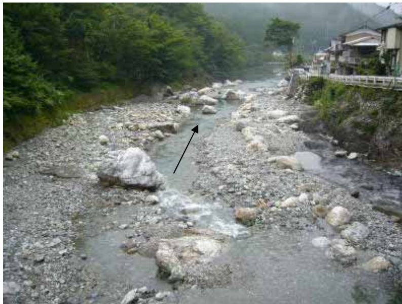
写真-15 平成16年、17年の土砂災害の影響で河床に堆積した土砂（名頃地区）
