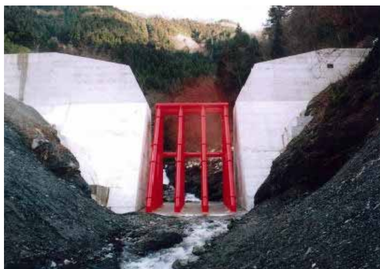
写真-28 西山谷第4えん堤
