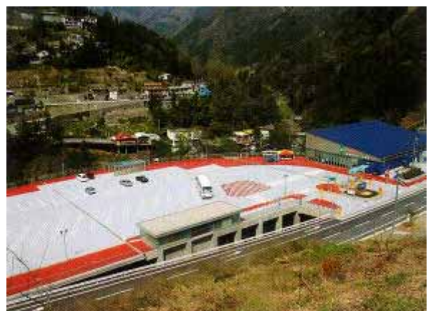
写真-17 かずら橋夢舞台（イベント広場兼駐車場、土産物屋）
