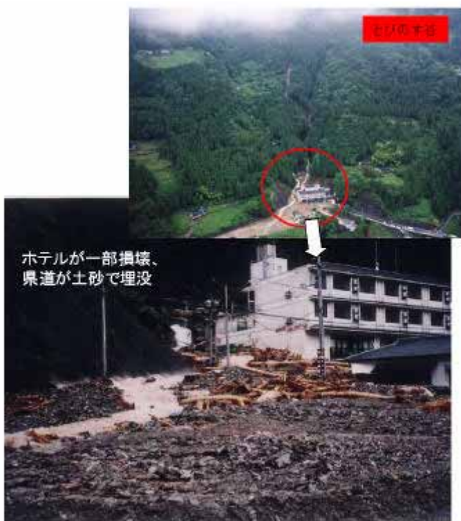
写真-10 平成11年6月梅雨前線豪雨によりとびのす谷で発生した土石流災害
