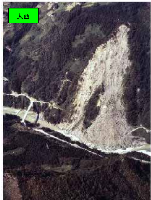
写真-9 昭和40年9月10日 台風23号により東祖谷の大西地区で発生した大崩壊
