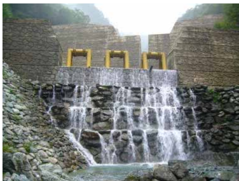
写真-27 菅生第4えん堤
