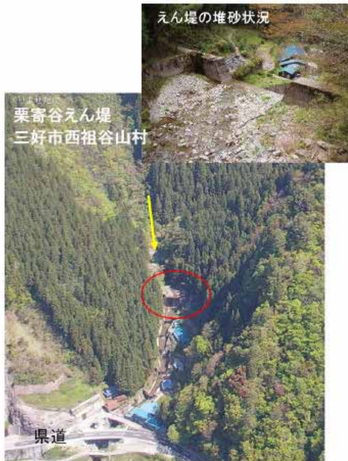
写真-13 直下の家屋や県道山城東祖谷山線（徳島県の緊急輸送路）を土石流から保全するえん堤
