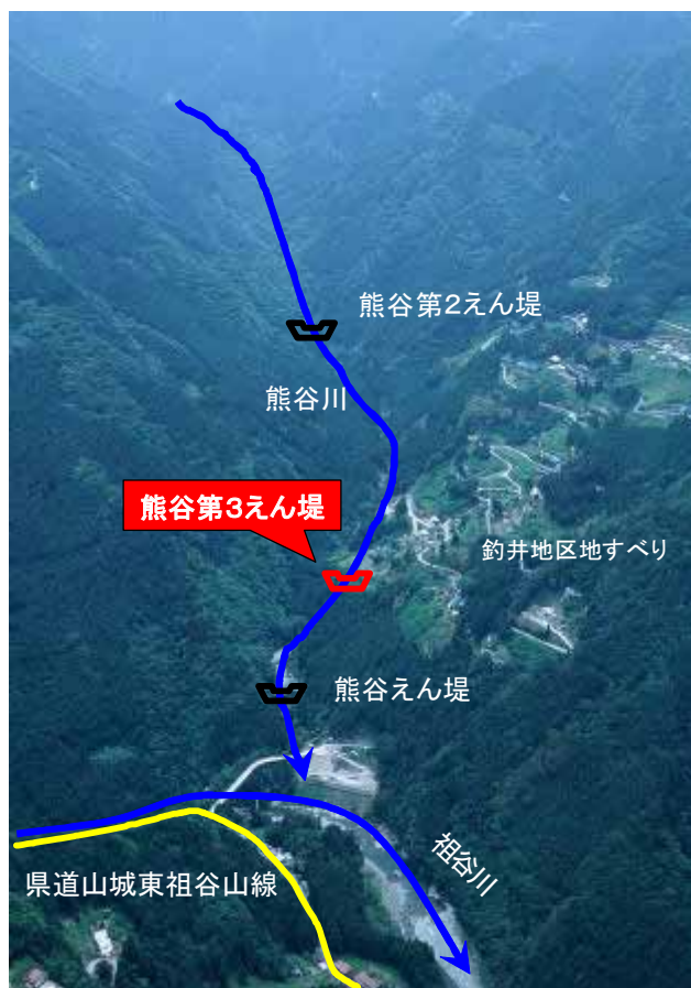
写真-2 熊谷第3えん堤整備箇所
