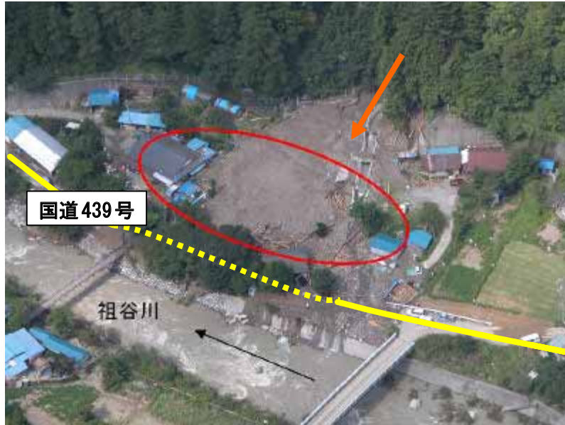
写真-14 平成16年8月台風16号豪雨により名頃地区で発生した土石流災害
