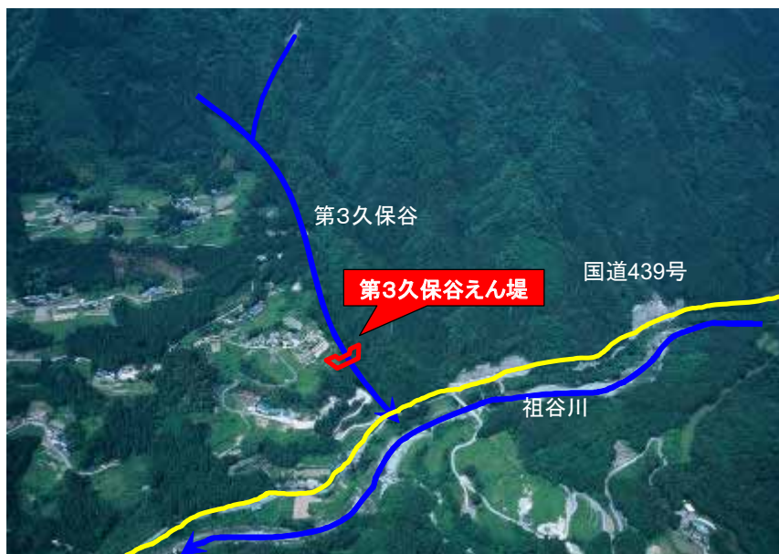
写真-3 第3久保谷えん堤整備箇所
