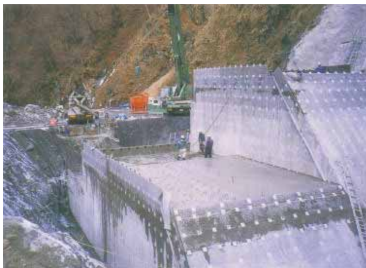
写真-26 若宮谷第 3 えん堤の施工例（残存埋設型枠採用） ざんぞんまいせつがたわく
