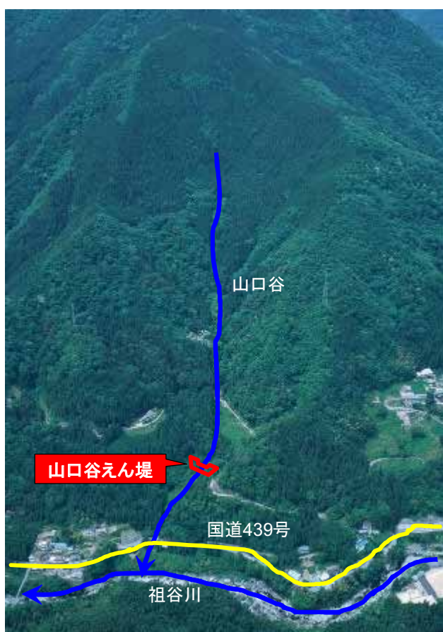
写真-4 山口谷えん堤整備箇所
