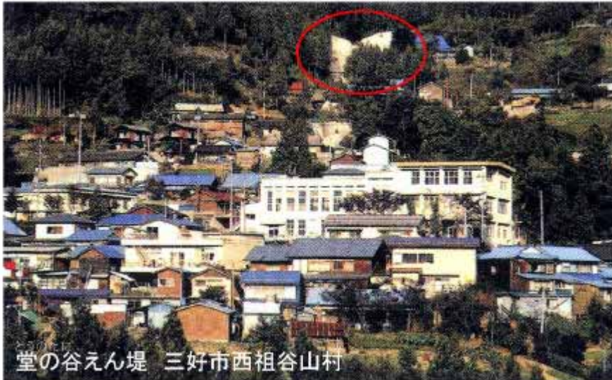
写真-12 家屋はもとより役場支所、消防署、小学校などの公共施設が密集する地域を土石流から保全するえん堤
