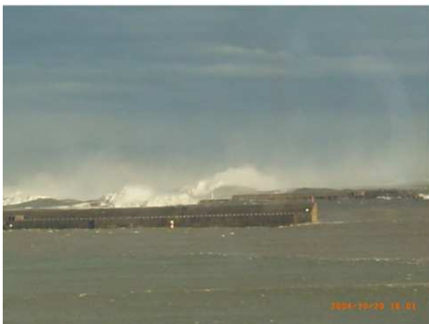
防波堤越波状況
