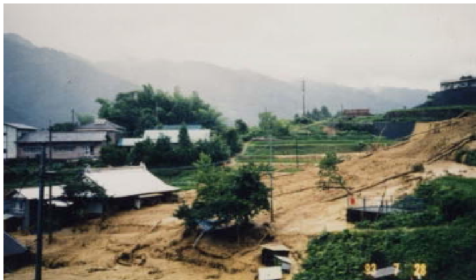
写真 - 7 平成 5 年 7 月台風 5 号による みつこの 三津子野地区の被害状況（南小川）
