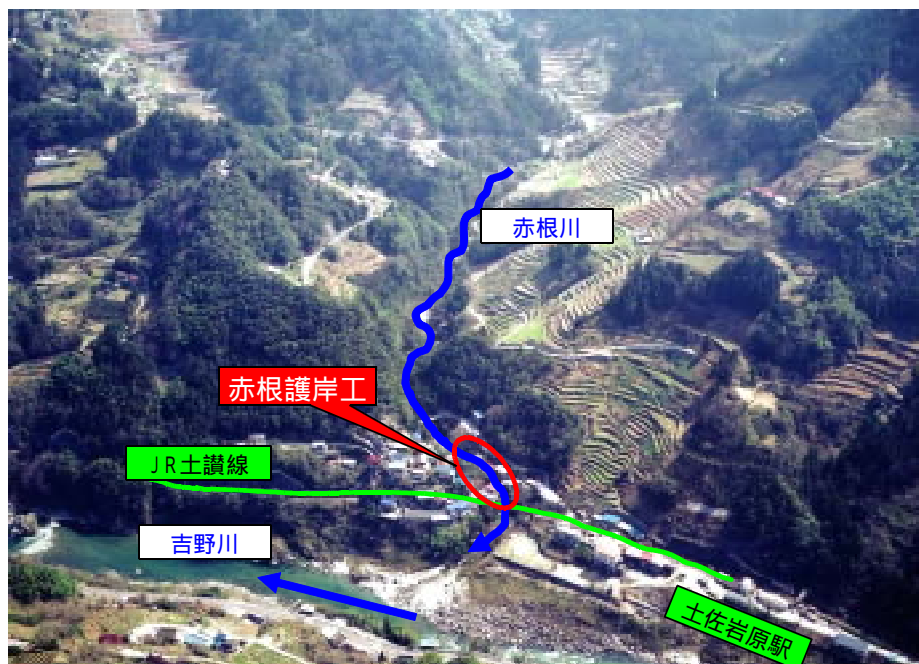
写真 - 2 赤根護岸整備箇所
