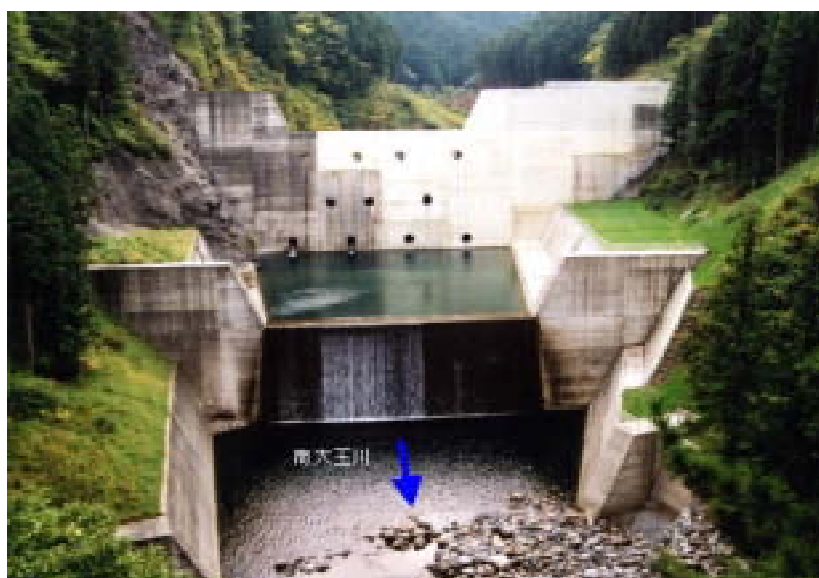
写真 - 15 四国最大級（えん堤高25.5m）の南大王第7砂防えん堤
