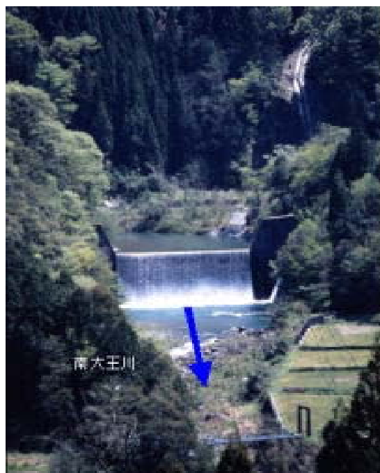
写真 - 14 吉野川直轄砂防事業1基目 の立野えん堤
