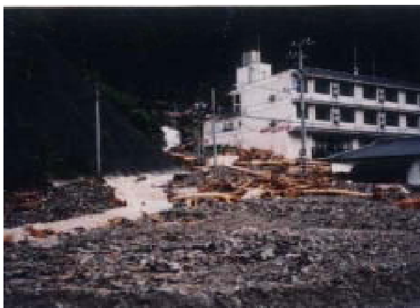
写真 - 8 平成11年6月梅雨前線豪雨による いやがわ 祖谷川の土石流災害
