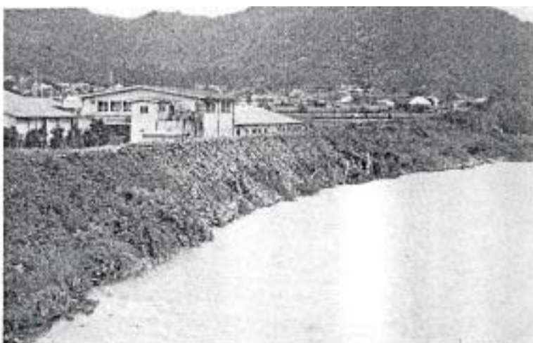
S. 51 台風 17 号で土器川、長尾堤防が欠壊し、木流しにより堤防を防いだ。
