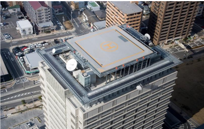
屋上ヘリポート（北館）
