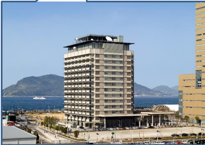
高松地方合同庁舎Ⅰ期（北館）
