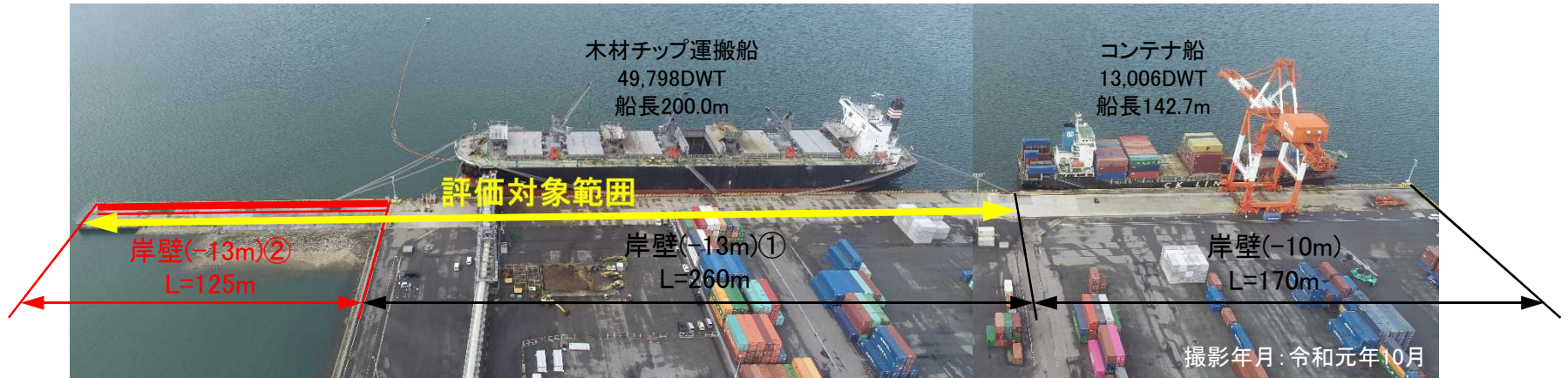
岸壁(-13m)①+岸壁(-13m)②の一体的な利用形態
