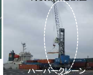
H24.10荷役機械を設置
