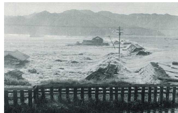
チリ地震津波被害状況(昭和35年)
