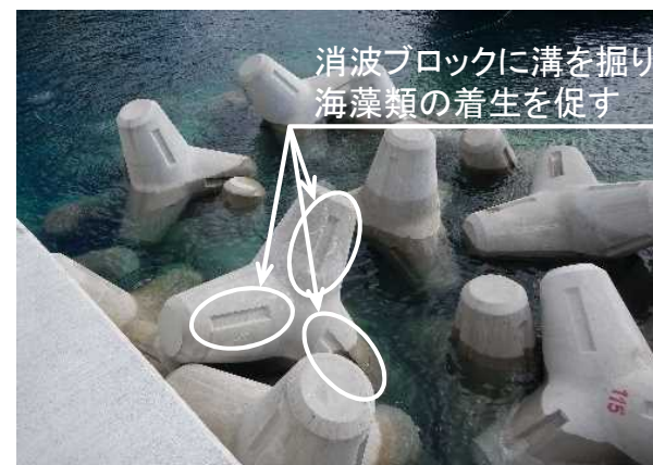
溝を掘った波消ブロックを海中に設置
