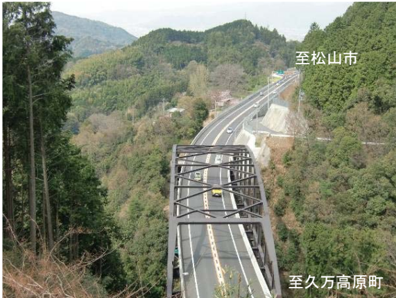
【写真①】三坂第二トンネル 松山側坑口
