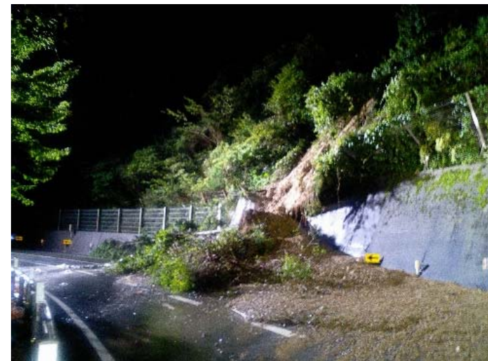
【写真】H16.9に発生した災害の様子
