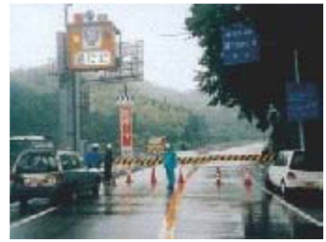
▲ 事前通行規制状況 (H22. 4)
