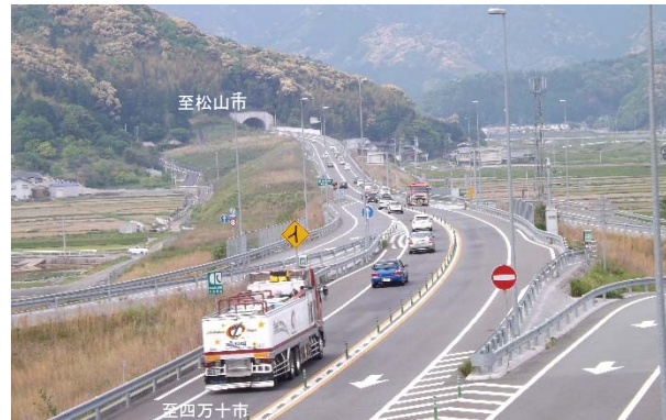
宇和島市三間町曾根（三間IC付近） 平成28年5月撮影
