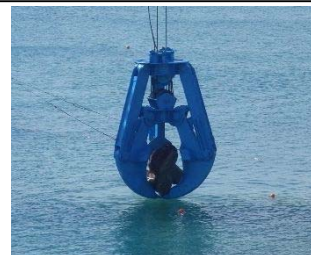
海底から撤去したブロック
