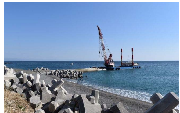
突堤(ケースン)延伸
