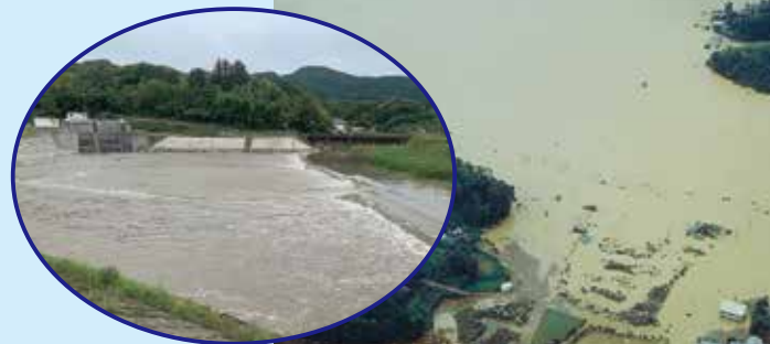
新日下川放水路 (呑回)
