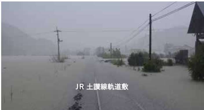
平成 26 年 8 月台風 12 号洪水の状況 (JR 冠水)
