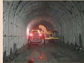
発破で砕いた岩石をトンネルの外へ運び出します。
