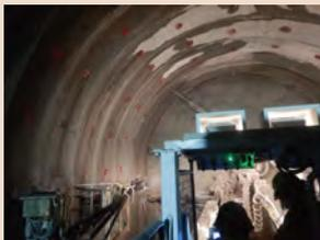
コンクリートを吹き付けた後、ロックボルトを挿入します。
