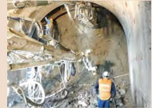
掘削面にコンクリートを吹き付けて、支保工を設置します。
