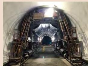
トンネル外周に覆工コンクリートを打設します。
