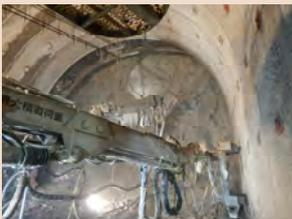
地山を安定させるため再度コンクリートを吹き付けます。
