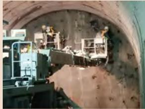
削孔した孔に爆薬を詰め岩盤を爆破します。
