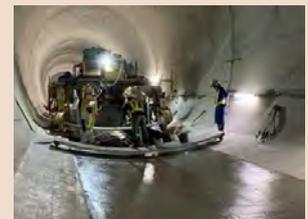
底盤のインバートコンクリートを打設します。
