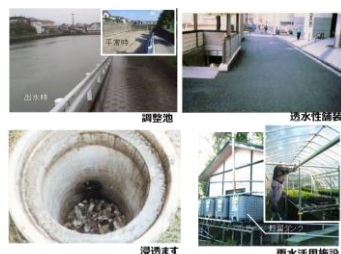
雨水貯留浸透施設の例
