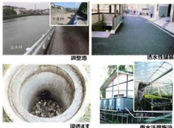
雨水貯留浸透施設の例
