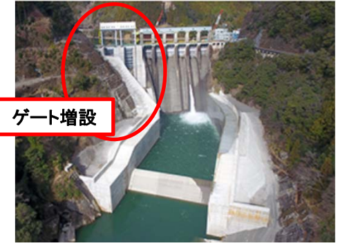
長安ロダムの改造事例
