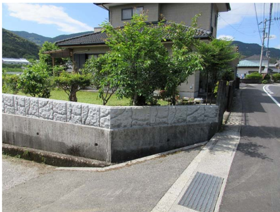
図 2-2-4 既存の擁壁を嵩上げすること等による輪中堤の建設（日高村）
