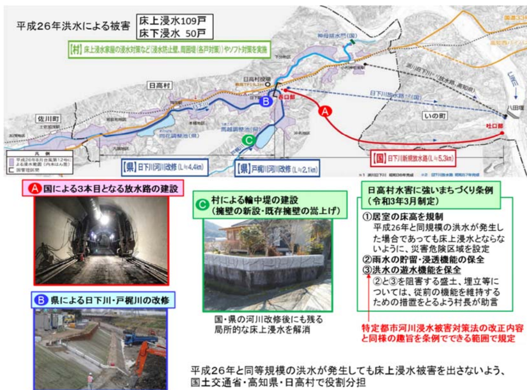
図 2-3-30 平成 26 年水害に対する治水対策 (国・高知県・日高村)
