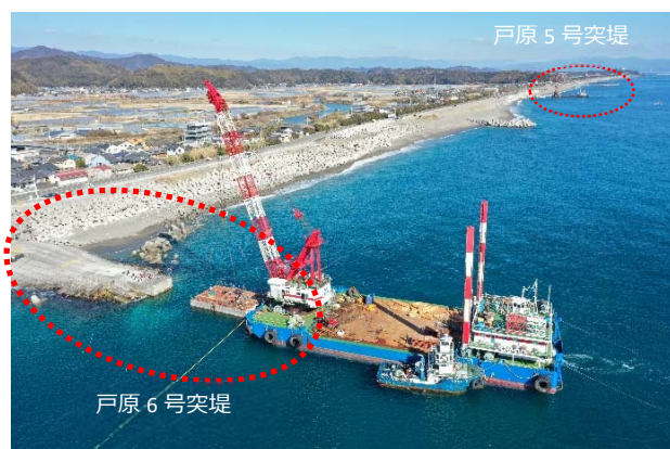
図 2-1-15 戸原 6 号突堤の延伸作業状況
