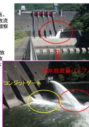
図 2-1-7 大渡ダム放流における（振動、臭い、濁水）の対策
