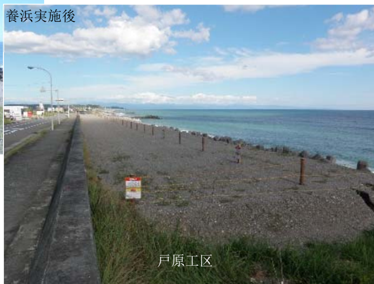
図 2-1-17 河道掘削による土砂を活用した海岸養浜
