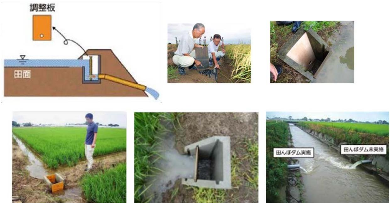
図 2-1-37 水田貯留の例（写真：新潟県 HP 田んぼダム写真より）
