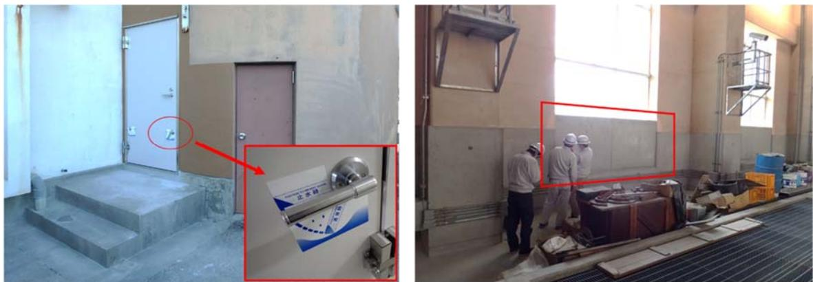
図-2-3-26 宇治川排水機場建屋の耐水化（左：止水ドア、右：止水壁）
