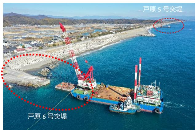
図 2-1-15 戸原 6 号突堤の延伸作業状況
