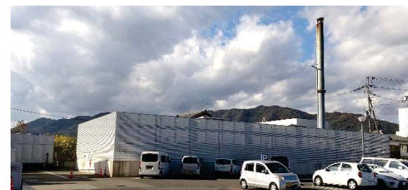
エネルギーセンター
