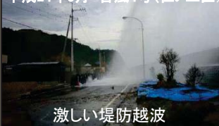
越波によるガードパイプの倒壊
