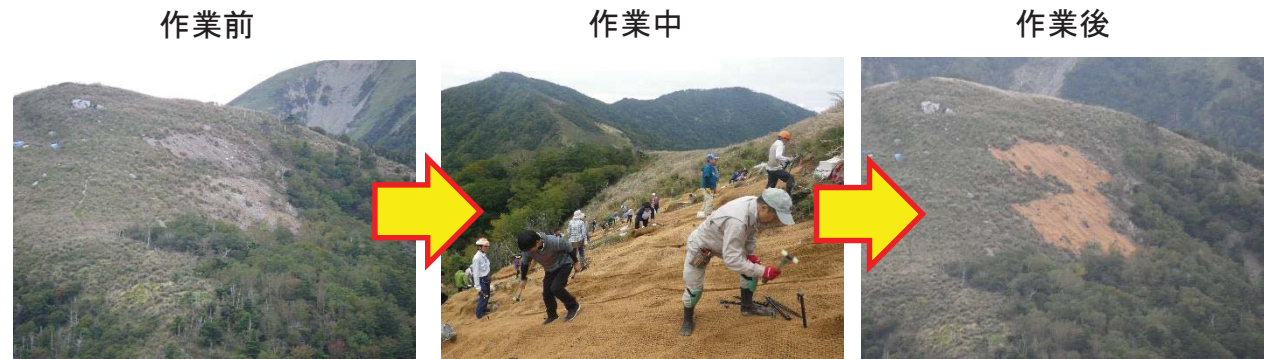
土砂流出防止・樹木再生回復用マット張り作業
