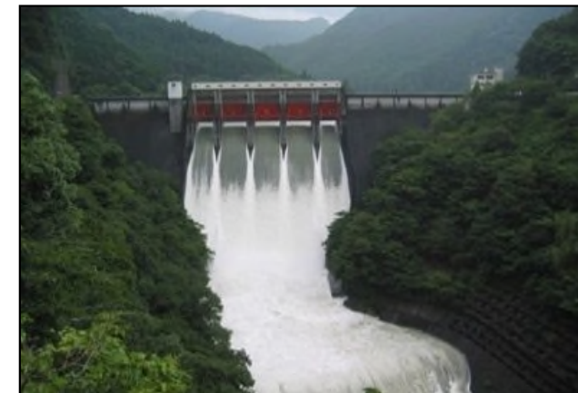
永瀬ダム（多目的ダム）
