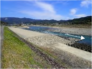
高水敷の造成(山田箇所9.2k付近)
