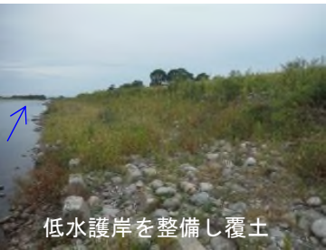
水衝部は巨石を用いた強固な護岸を整備
