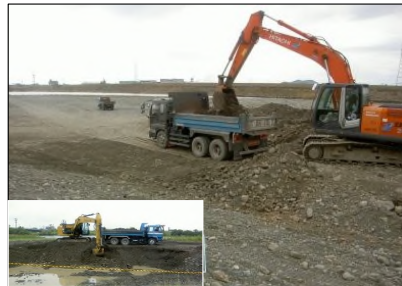
4k/0付近の河道掘削状況
