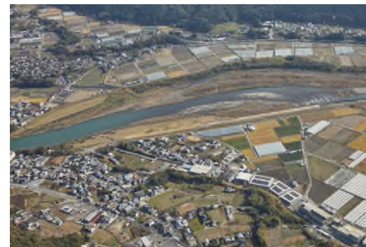
堤防断面 R4. 11月撮影
