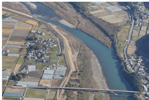
引堤R4. 11月撮影
