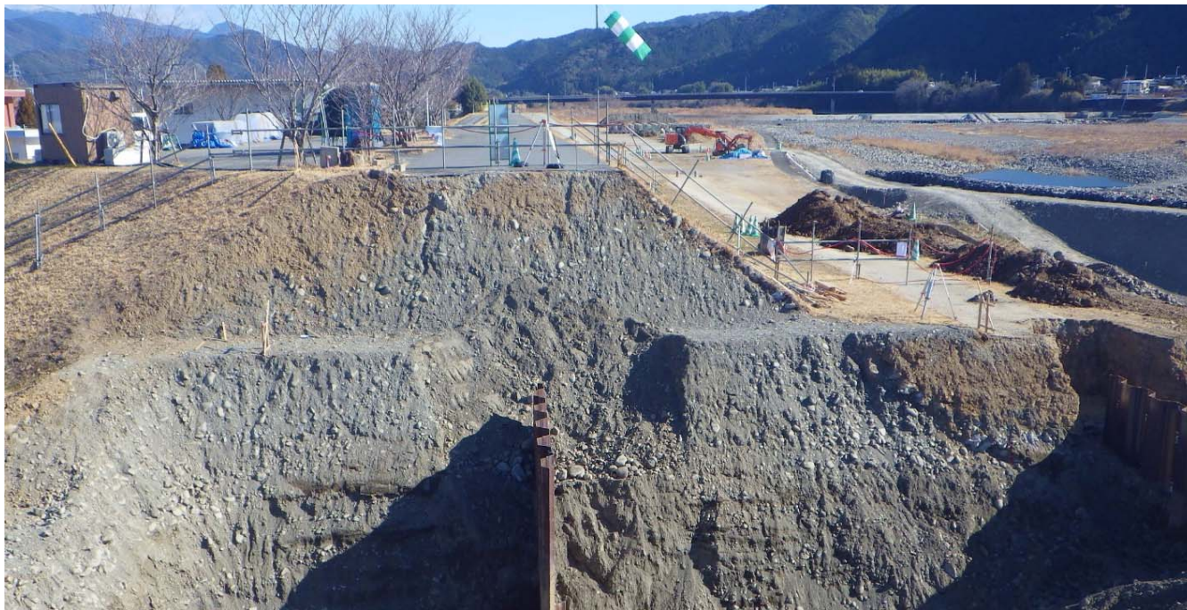
開削状況(全景)
