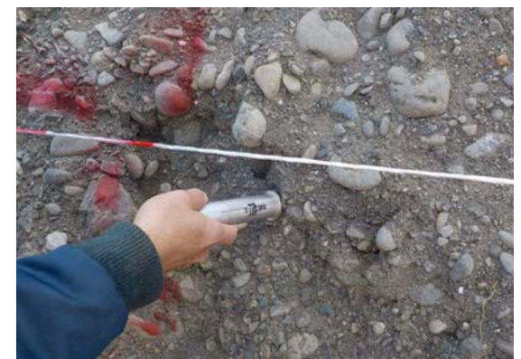
堤防調査状況
