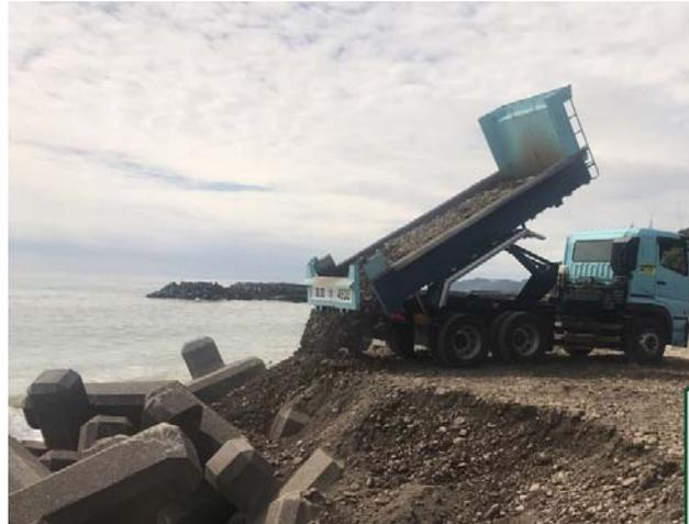
図 2-1-18 物部川の河道掘削土を活用した海岸養浜の例
