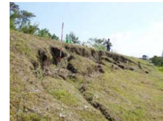
(b) (a) のすべり面上端部の状況
