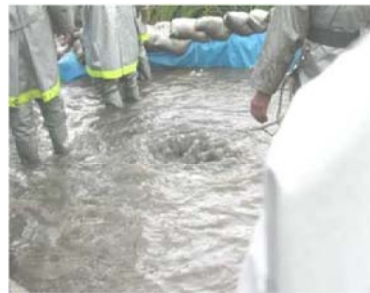
(c) 噴砂を伴う漏水の状況
