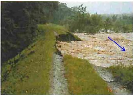
写真 - 11 天端まで侵食が進行した事例
