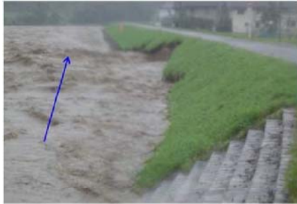
写真 - 7 表法面の侵食が発生した事例
