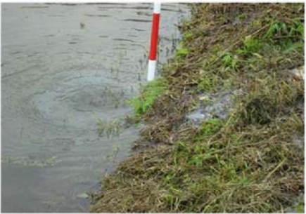
写真 - 2 法尻からの漏水の事例
