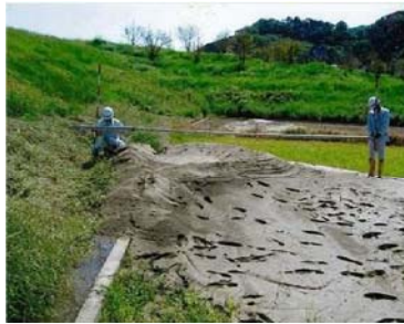
(d) 堤脚水路脇で生じた噴砂
