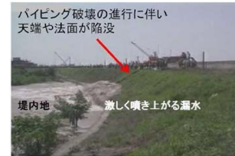
写真 - 9 激しく噴き上がる漏水によって天端や法面が陥没した事例
