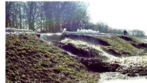
写真 - 10 堤防天端に達するすべりが発生した事例
