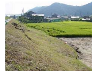
(a) すべりによる堤防の破壊事例
