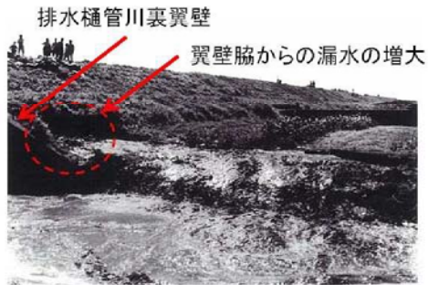
写真 - 8 排水樋管川裏翼壁脇からの漏水
