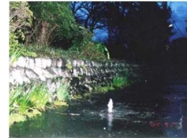
写真 - 4 法尻付近の堤内地から噴き上がる漏水
