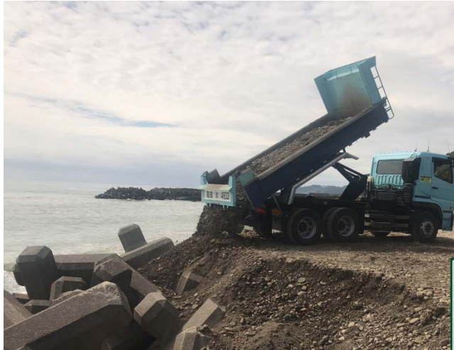
図 2-1-19 物部川の河道掘削土を活用した海岸養浜の例
