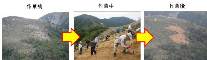
土砂流出防止・植生回復用マット張り作業
