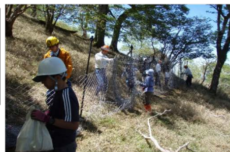
シカ食害防護柵の設置作業
