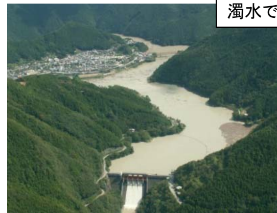
永瀬ダム (H17.9.12 中央東土木事務所撮影)
