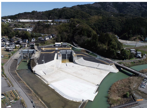
写真1-4 新日下川放水路
