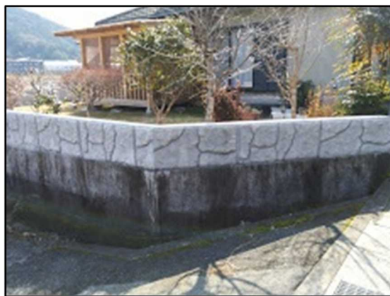
写真9-1 擁壁の嵩上げ
