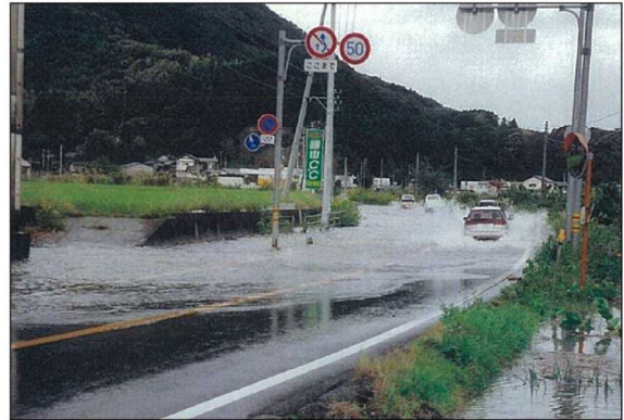
【梅ヶ坂地区の国道33号の冠水状況】
