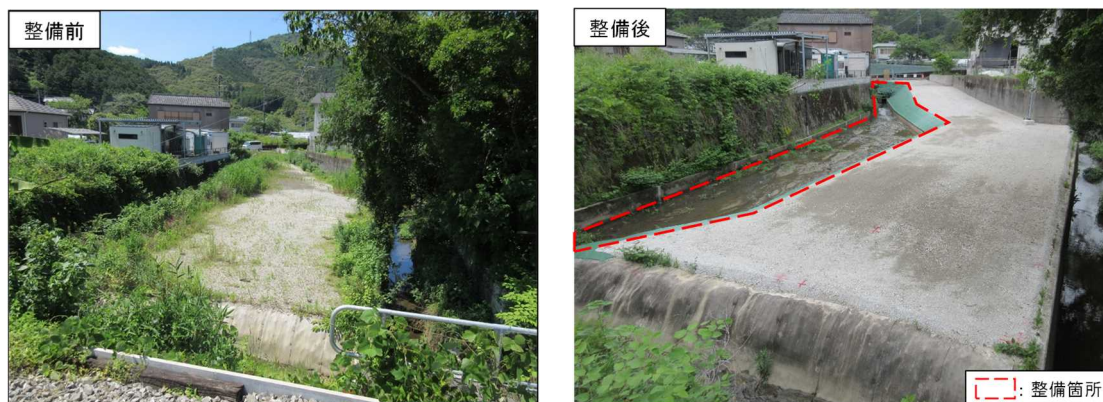
写真4-3 日高村が行う水路の整備（岡花地区）
