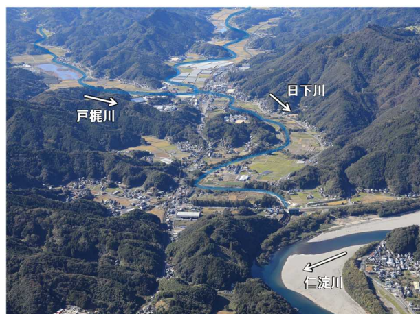
写真1-1 日下川流域（仁淀川合流部付近）
