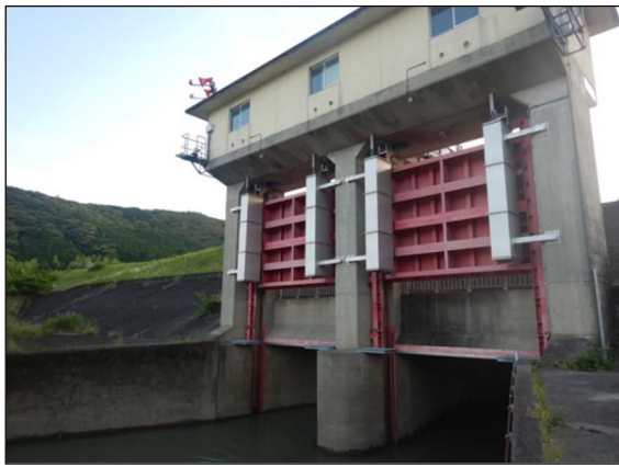
写真4-1 日下川放水樋門
