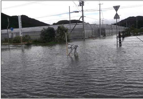
【トマト栽培ハウスの浸水状況】
