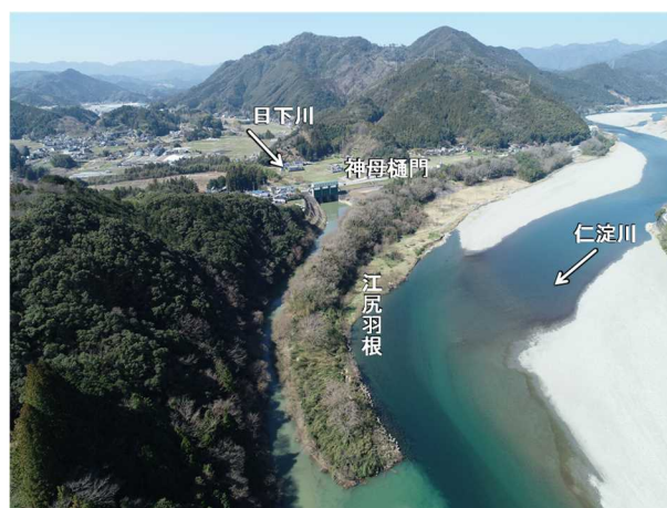
写真1-3 神母樋門と江尻羽根
