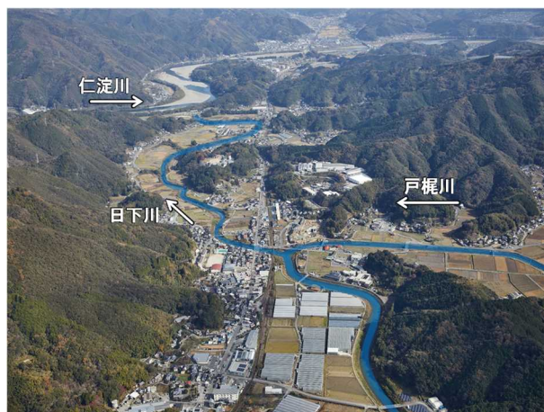
写真1-2 日下川流域（戸梶川合流部付近）
