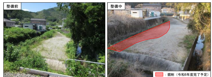
水路の整備（岡花地区）
