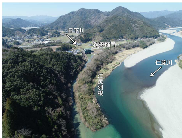
写真1-3 神母樋門と江尻羽根
