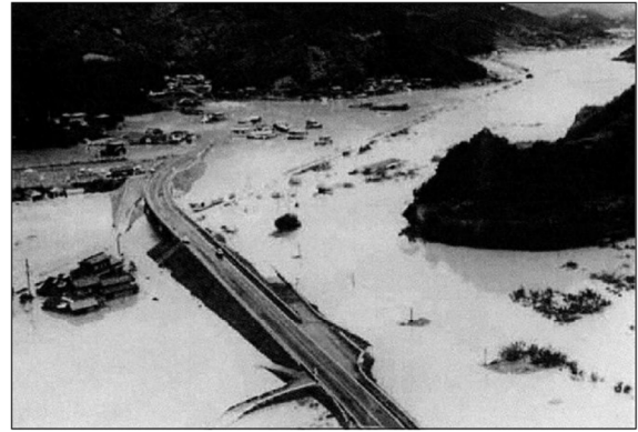
【岡花付近：R33号下のJRは水没している】
