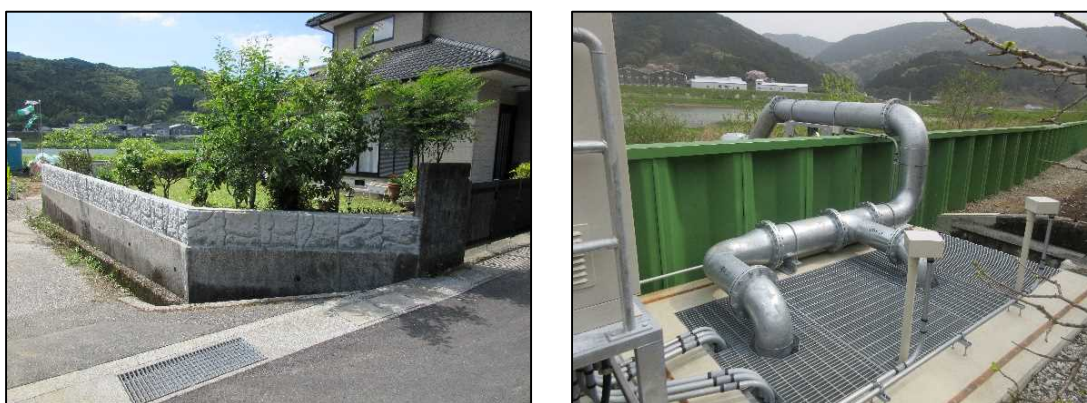
写真4-4 浸水防止壁と雨水排水ポンプ（馬越地区）
