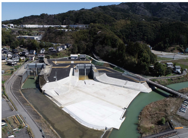
写真1-4 新日下川放水路
