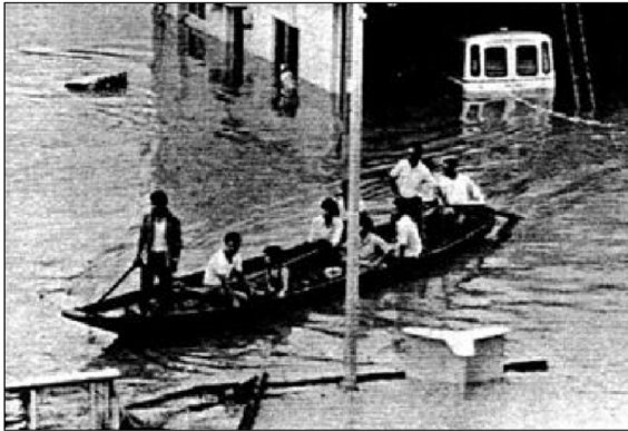
【仁淀消防組合日高分署付近】
