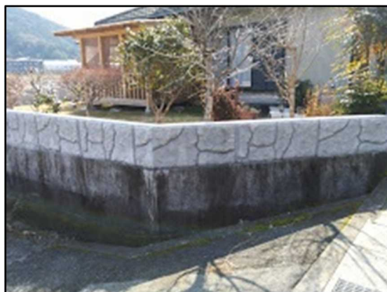
写真9-1 擁壁の嵩上げ
