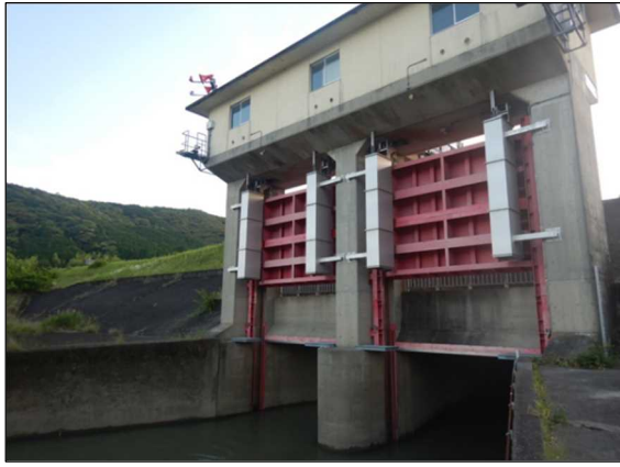
写真4-1 日下川放水樋門
