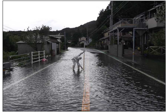
【岡花地区の国道33号冠水状況】
