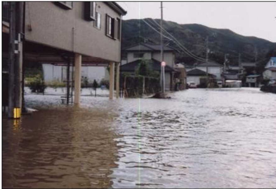
【馬越地区の浸水状況】
