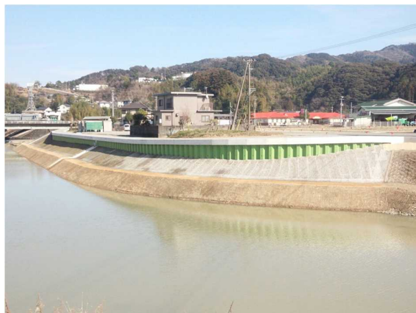
写真1-5 日下川河川改修状況
