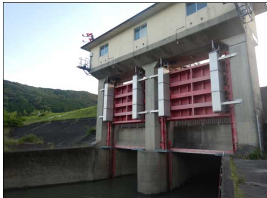
日下川放水樋門
