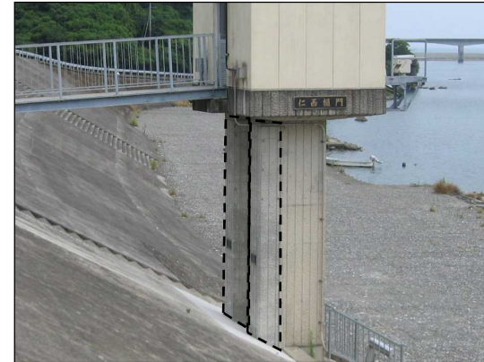
耐震対策例（門柱補強：仁西樋門）
