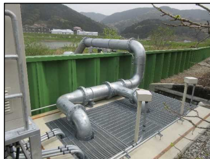
雨水排水ポンプの整備
