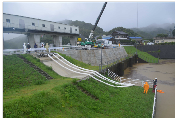
排水ポンプ車による排水状況（平成26年8月台風第12号）
