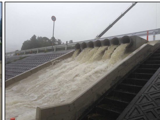
排水ポンプ車による排水状況（平成26年8月台風第12号）
