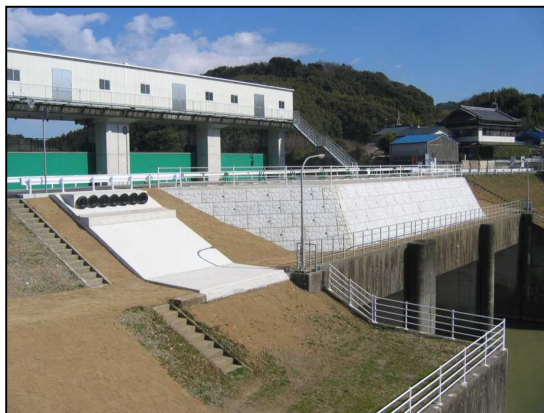
神母樋門に整備した排水ポンプ車のヤード
