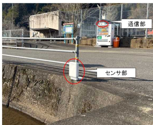
浸水センサ設置事例（西田地区）
