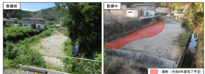
水路の整備（岡花地区）
