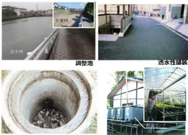
雨水貯留浸透施設の例
