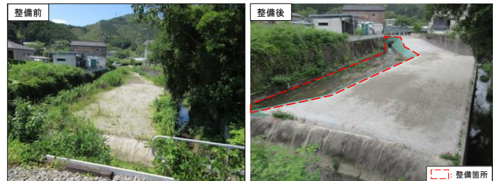
水路の整備（岡花地区）
