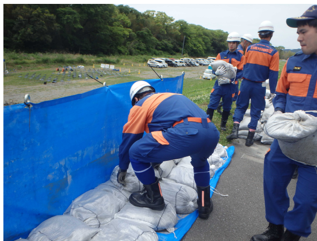
越水対策（改良積土のう工）
