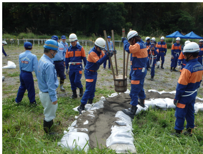
漏水対策（月の輪工）
