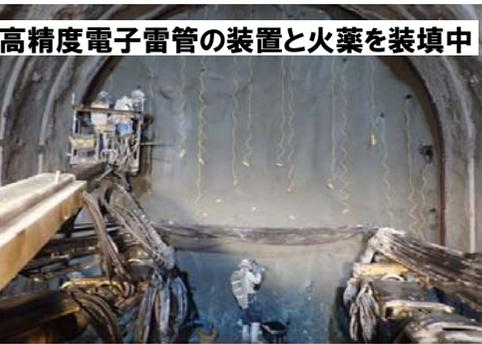
高精度電子雷管の装置と火薬を装填中
