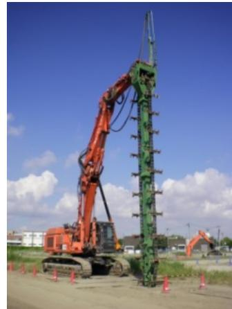
➢ 中層混合処理工法(パワブレンダー等)を用いることで約10mの深さの土壌に対して固化剤を均一に混ぜる事が可能に。
